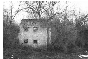
Torzo statku v bývalém Mladoňově
